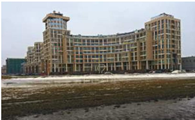
Ил. 44. Жилой комплекс «Omega House», Санкт-Петербург, Петроградская сторона. Каркас здания выполнен из монолитных ж/б конструкций бетона класса по прочности В25
