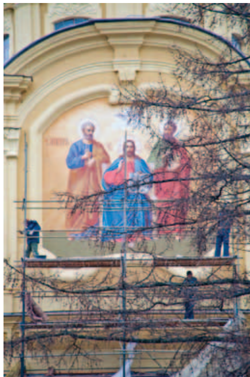
8. Демонтаж лесов после завершения воссоздания композиции «Предстояние святых апостолов Петра Павла Спасителю» Декабрь 2013 г.
