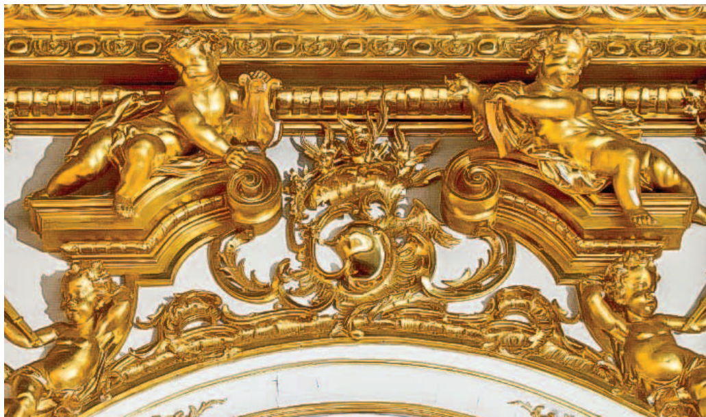
6. Фрагмент декора Тронного (Большого) зала Екатерининского дворца в Царском Селе Вид после реставрации: резной декор полностью перезолочен
