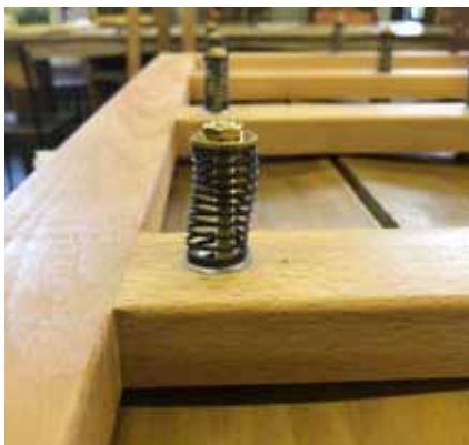
18. Элемент регулируемого крепления
